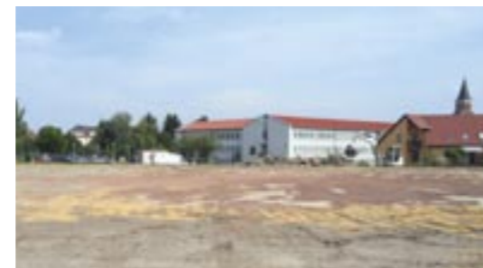
Die Vorbereitungen des Baugrundes sind abgeschlossen – jetzt geht der Aufbau los.
